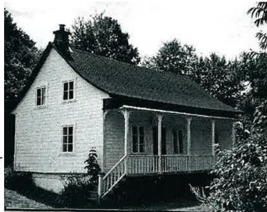
Bâtiment témoin : 1283, Principale PRSF01Principale1283
