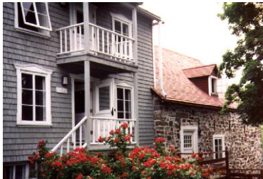
Moulin à vent et à eau Desgagnés, Ile-aux-Coudres, 247, du Moulin IAC01Moulin, 247
