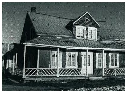
Bâtiment témoin : 21, rang Ste-Croix, SHL ; P 03.14 A
