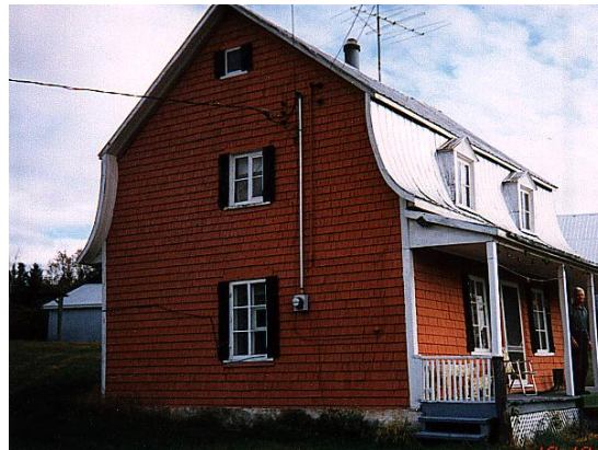
Bâtiment témoin : 84, rang du Moulin, SHL ; SHI99du Moulin, 84
