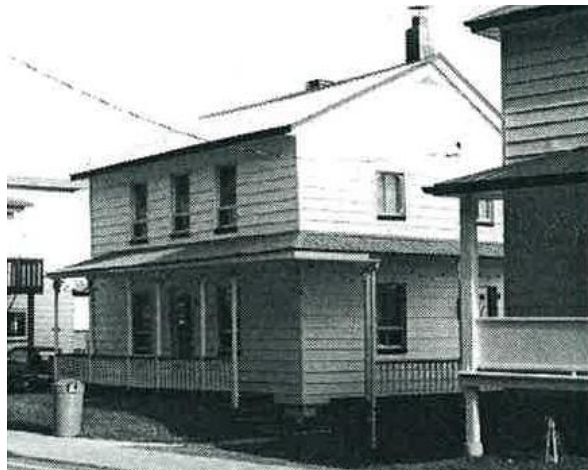
Bâtiment témoin : 987, rue Principale, PRSF P 08.15 A
