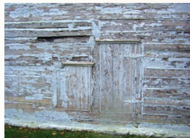
Le chaulage donne une coloration d'un blanc laiteux aux bâtiments.
