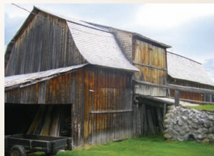
Toutes les composantes de cette grange-étable sont en bois, y compris son toit en bardeau.
