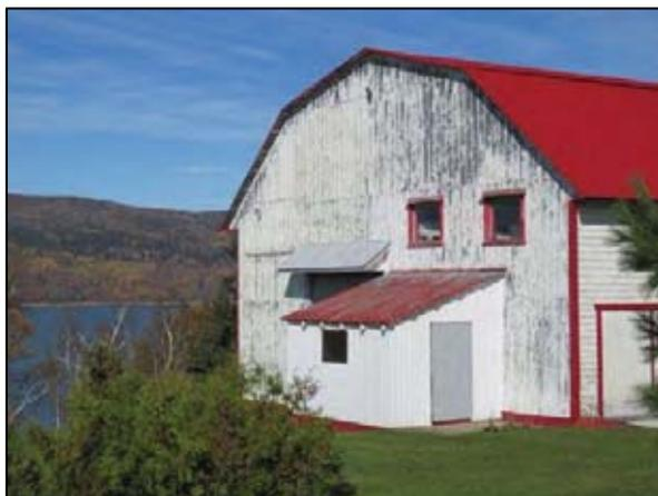
Planches cornières permettant la transition entre deux types de matériaux, à l'angle de la structure, visible sur la grange située au 1224, chemin des Coudriers, L'Isle-aux-Coudres.
