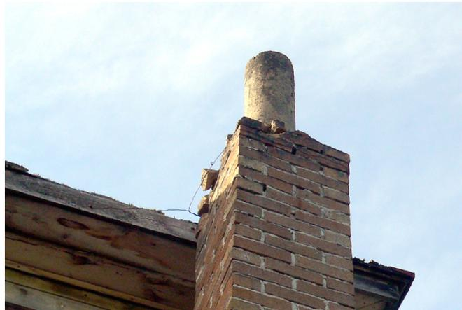
54. La partie haute de la cheminée en brique se désagrège. L'eau peut ainsi entrer dans la maçonnerie et dégrader l'ouvrage. Source : Patri-Arch, 2011.
