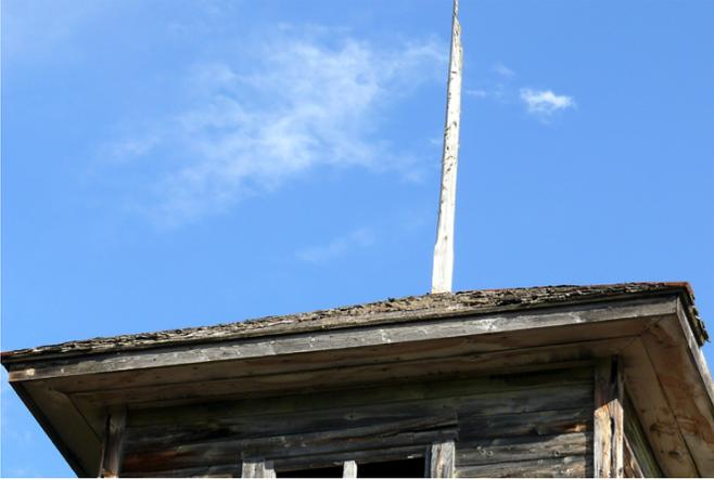
42. La toiture en pavillon (à quatre versants) du dernier étage coiffé d'un mât. Source : Patri-Arch, 2011.
