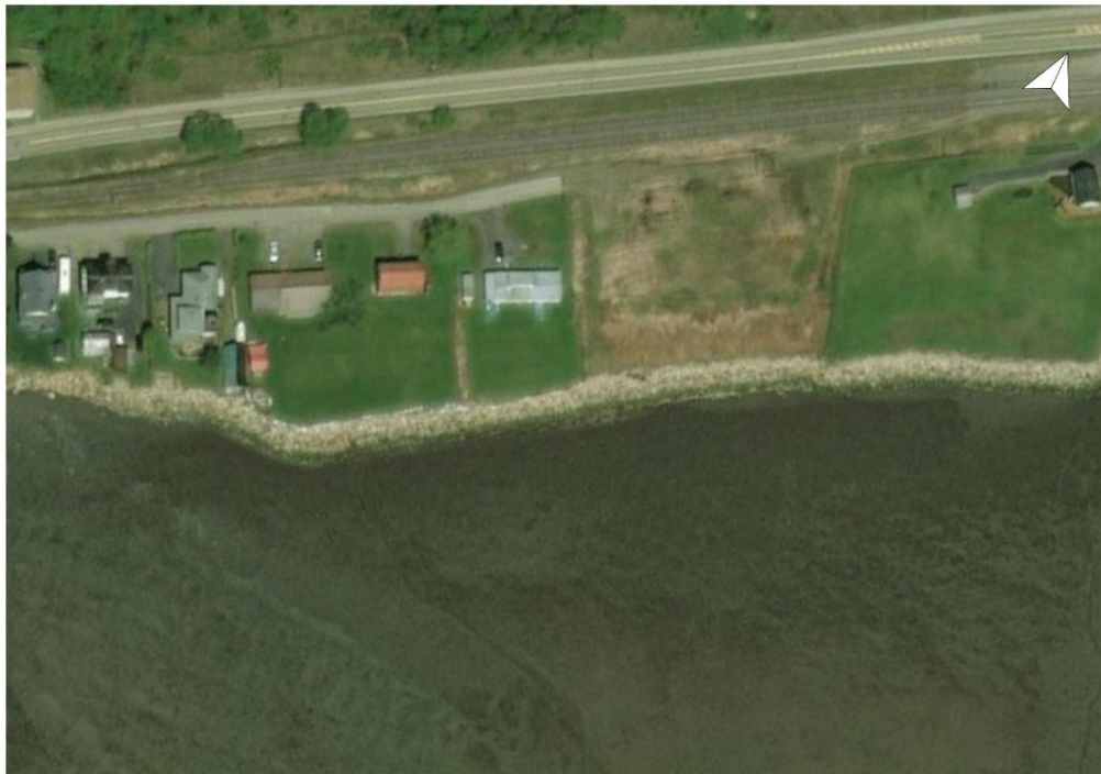
Photo 5. Enrochement des berges du périmètre urbain de Saint-Joseph-de-la-Rive (Bing satellite, 2020).
