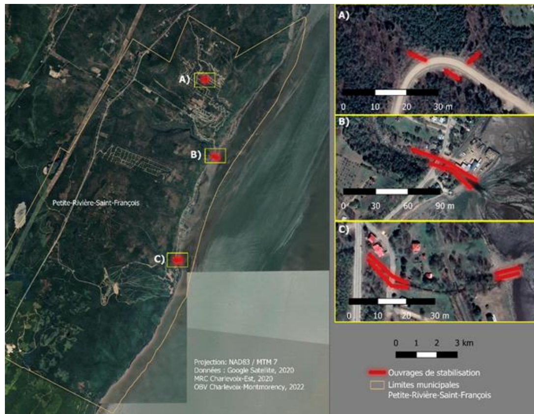
Figure 25. Ouvrages de stabilisation des berges présents à Petite-Rivière-Saint-François.
