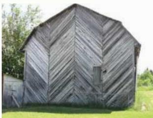
La **planche oblique**, disposée en diagonale, permet de solidifier la charpente en jouant le rôle de contreventement [élément d'une construction installé pour prévenir les déformations]. De plus, cette technique offre un aspect décoratif intéressant. Dans certains cas plus élaborés, ce type d'assemblage produit un véritable effet de marqueterie.
