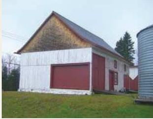
Le **bardeau de cèdre** résiste très bien à l'eau et à l'humidité. De ce fait, il recouvre autant les toitures que les murs particulièrement exposés aux intempéries. Ces minces planchettes de bois fendues sont assemblées de façon que les joints et les trous de clouage soient protégés par la rangée supérieure de bardeaux.
