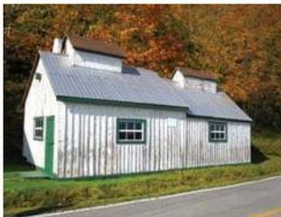
La **planche à couvre-joint** est un type d'assemblage formé de planches de bois apposées verticalement. Les interstices sont recouverts de baguettes de bois qui visent à étanchéifier le parement des murs. Plutôt rare aujourd'hui, cette méthode était fréquente autrefois.
