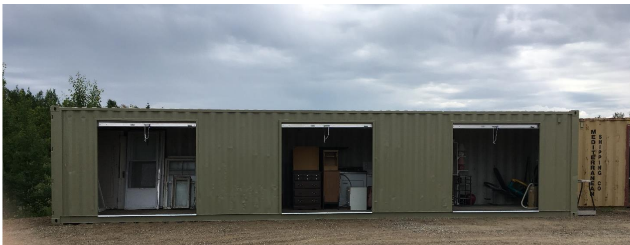
Figure 11. Infrastructure de revente Écocentre de L'Isle-aux-Coudres
