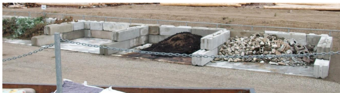
Figure 16. Casier de béton écocentre St-Urbain
