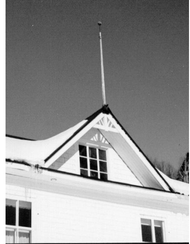
Élément architectural courant sur le territoire de la MRC, typique des maisons de navigateurs à PRSF. « Mât au sommet d'une lucarne » (Guide d'intervention du patrimoine, 2021). Photo : Martin Dupuis, Patri-Arch
